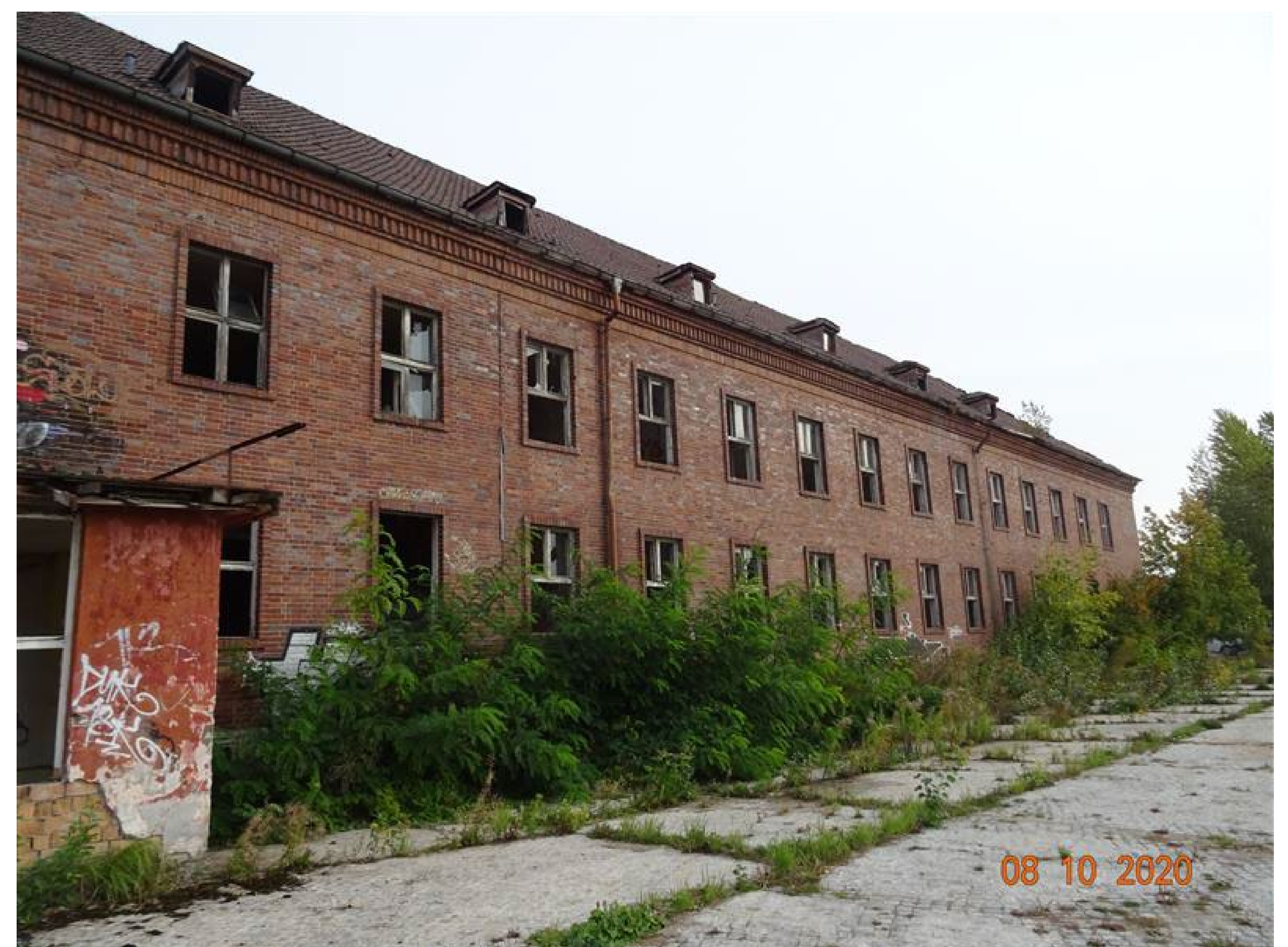
Abb.: Vorher Ansicht Gebäude Teil 2
