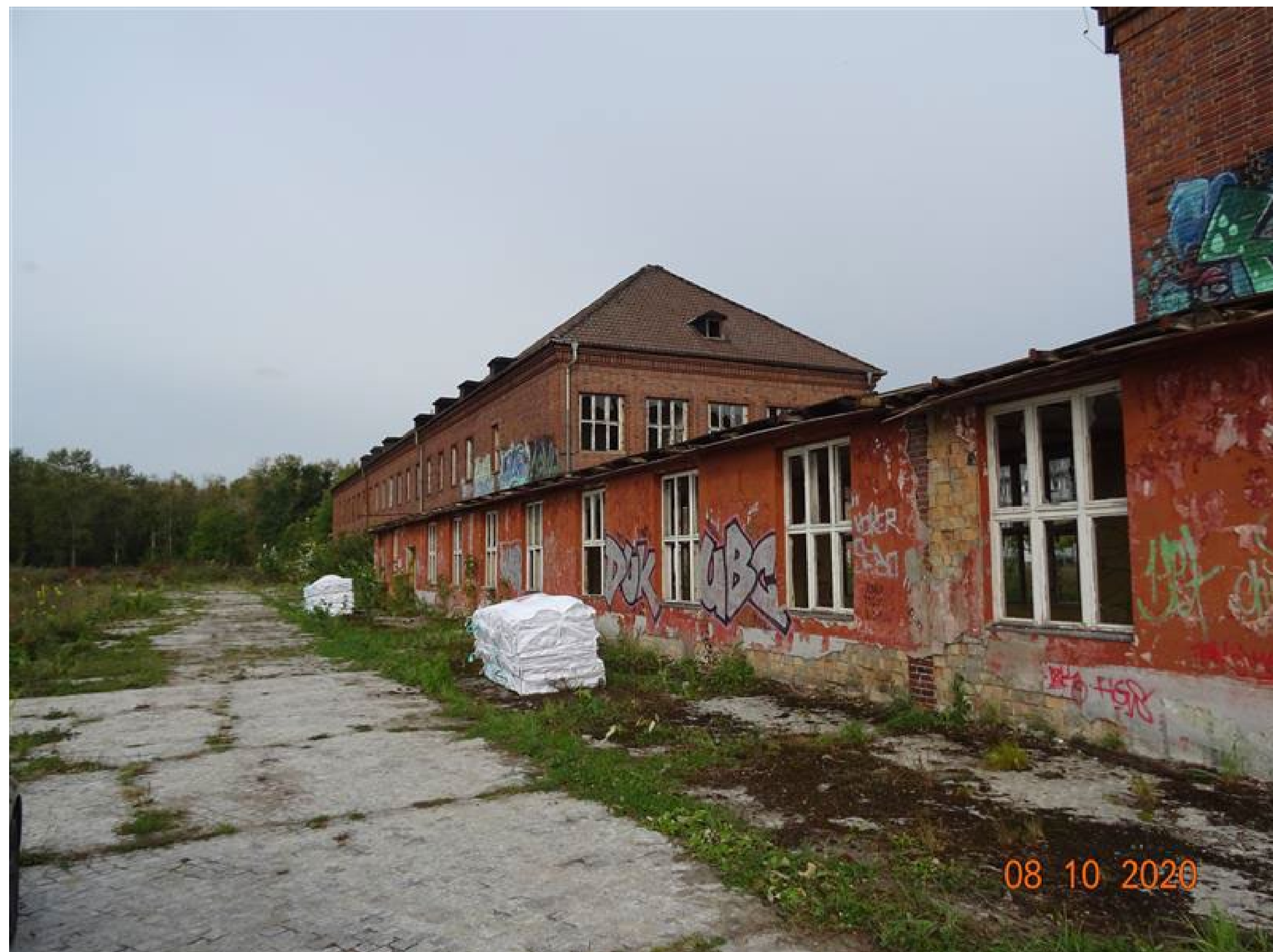
Abb.: Vorher Ansicht Nord-Ost Fahrradabstellräume
