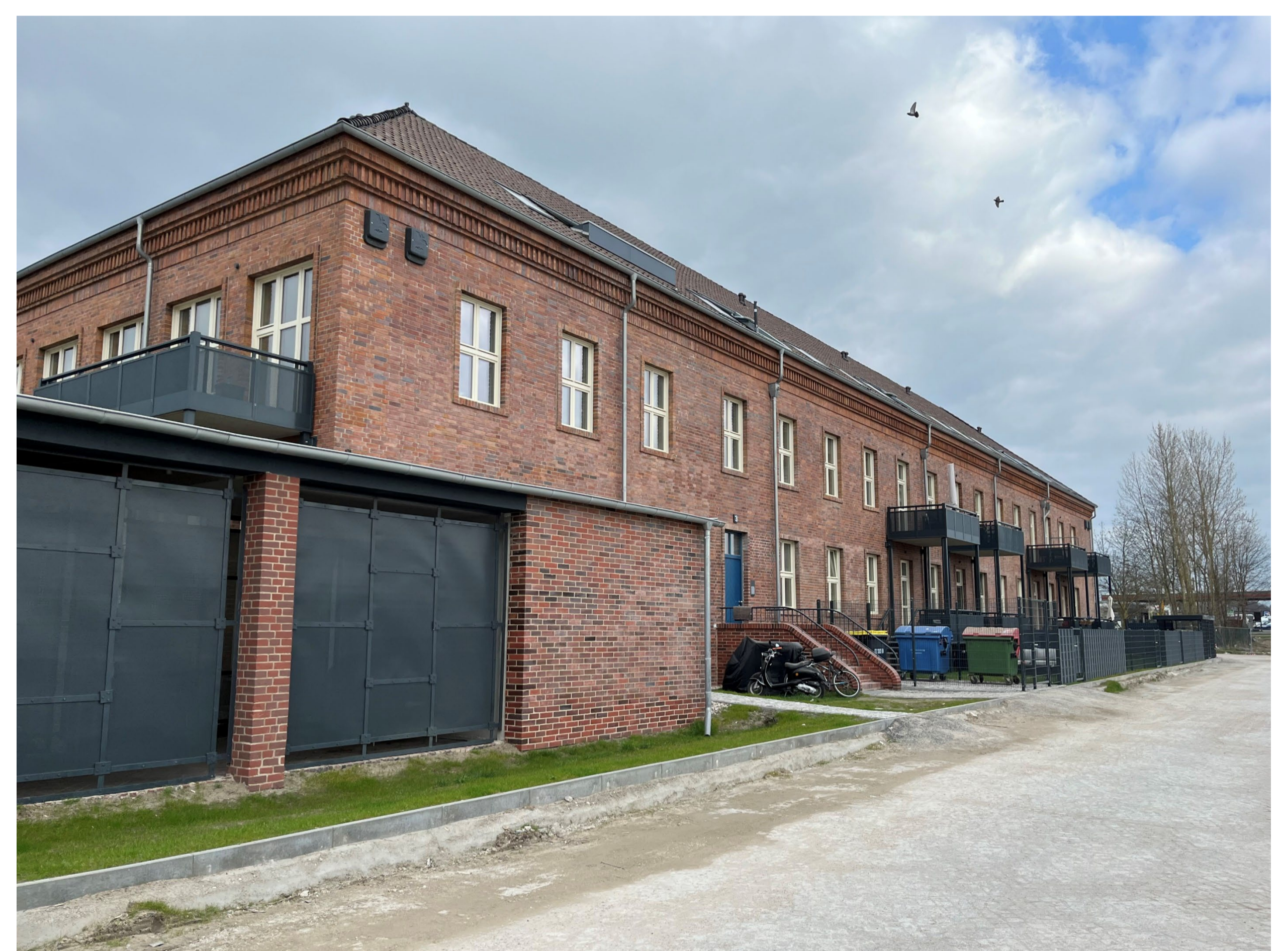
Abb.: Nachher Ansicht Gebäude Teil 2
