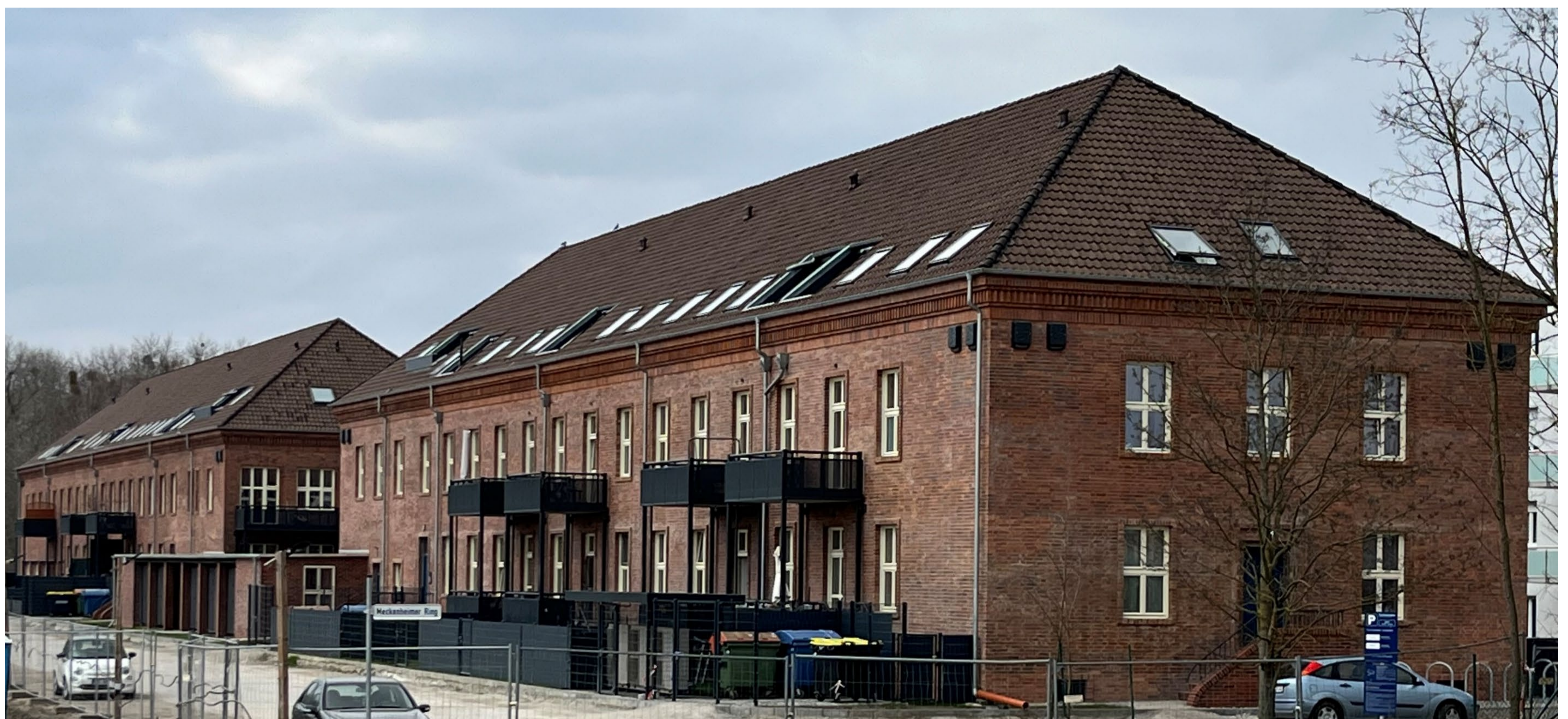
Abb.: Ansicht Nord–Ost Gebäude Teil 1 + 2
