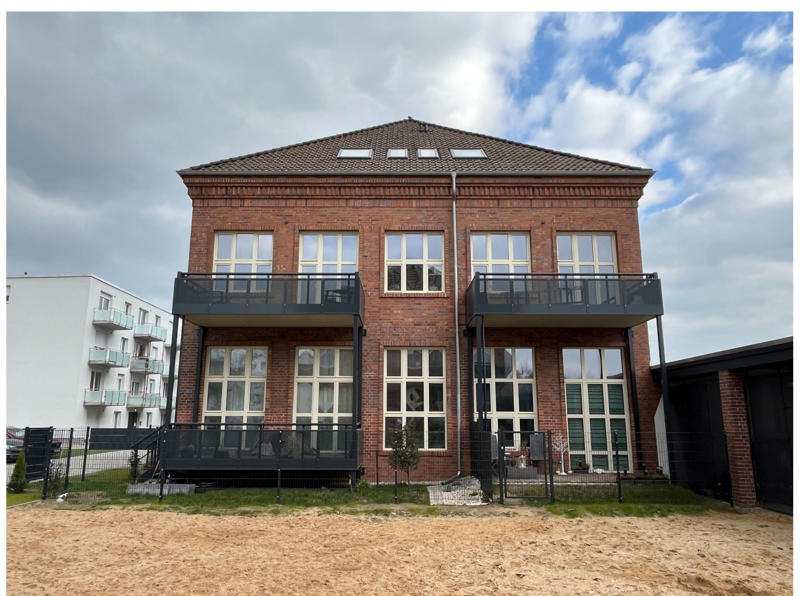
Abb.: Ansicht Süd-Ost Gebäudeteil 1
