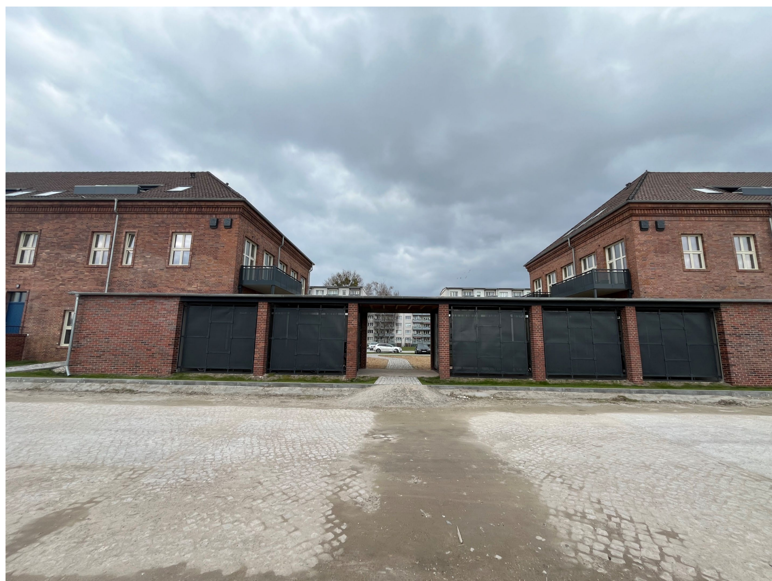
Abb.: Nachher Ansicht Nord-Ost Fahrradabstellräume
