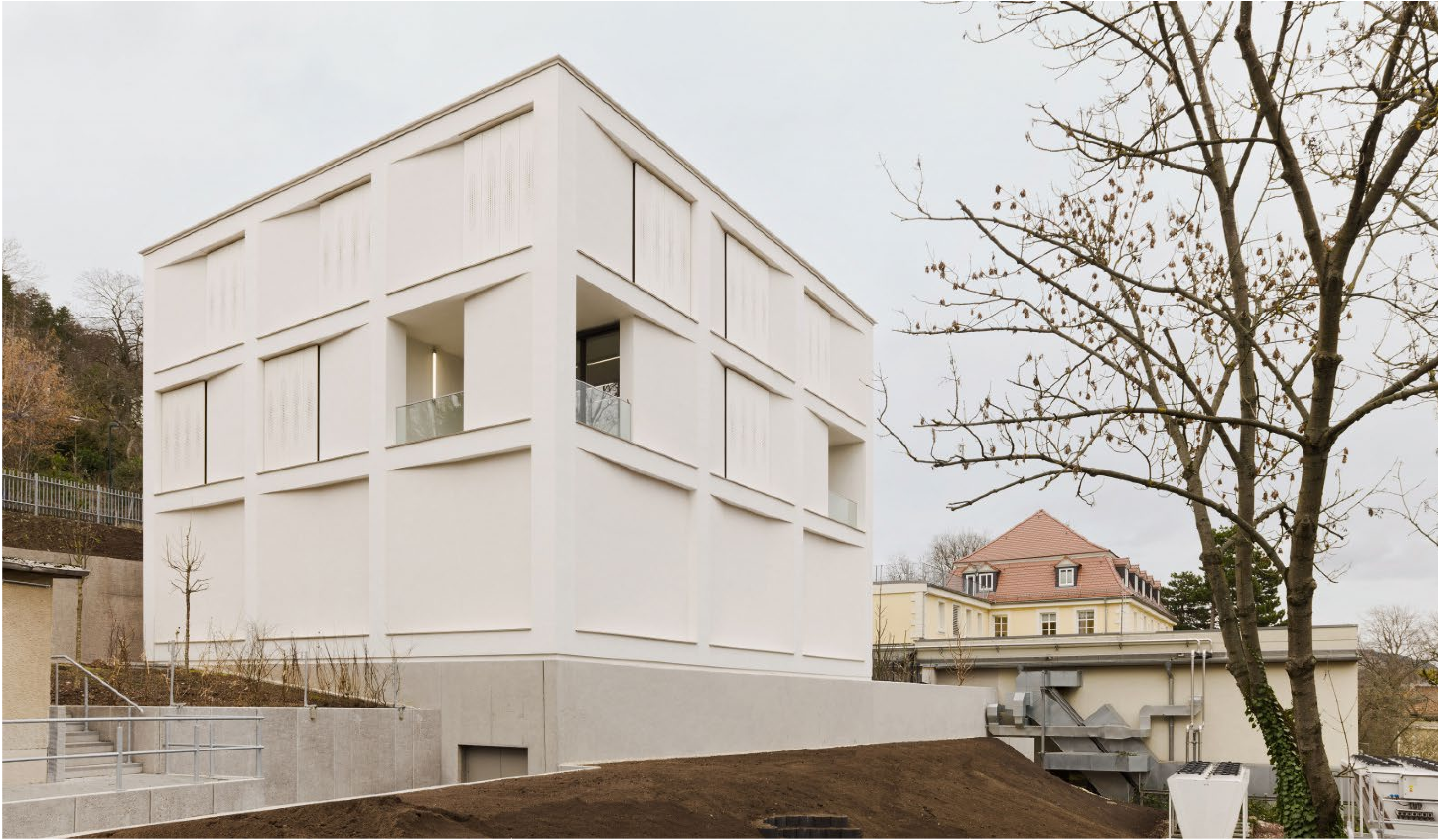
Abb.: Außenansicht von der Talseite
