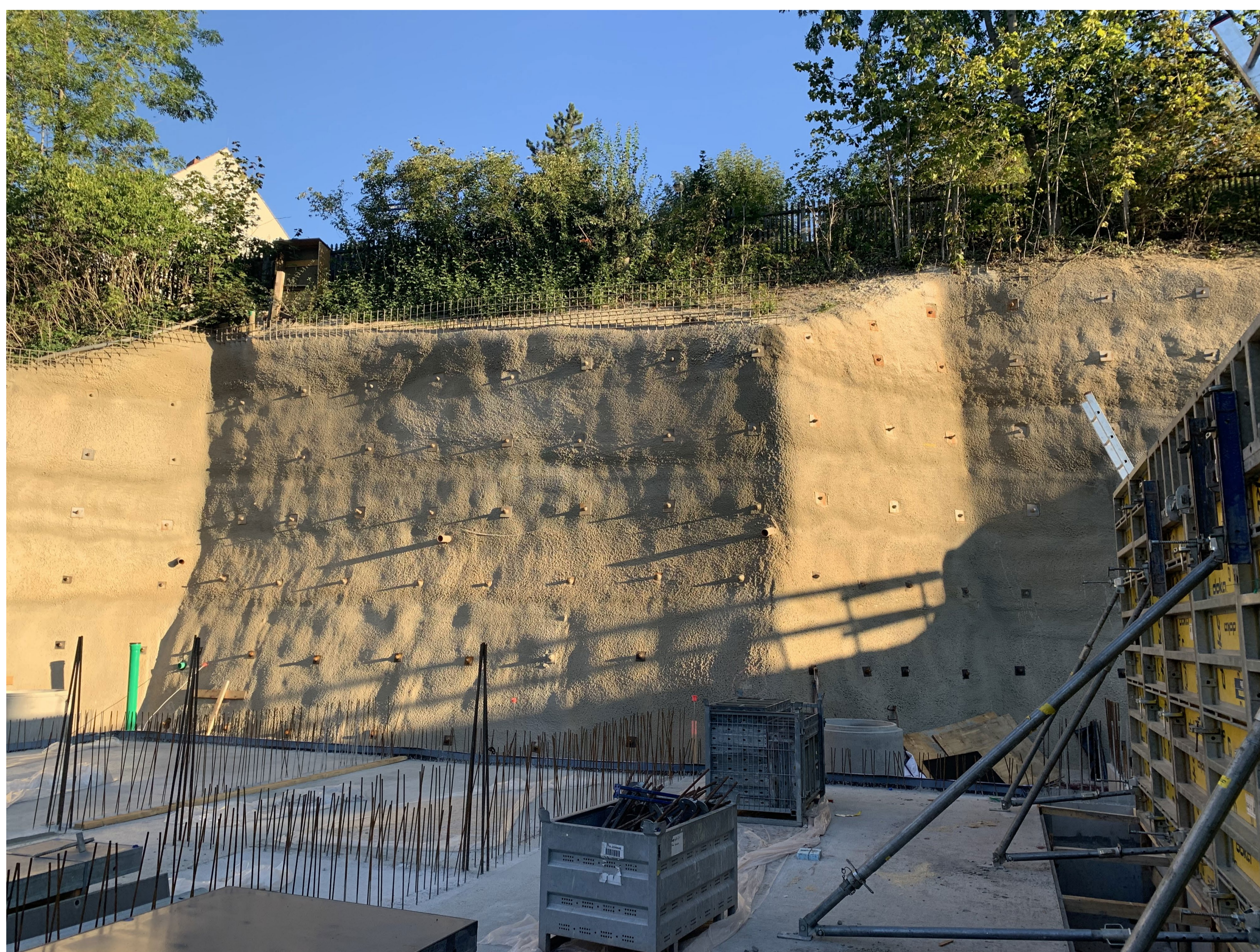
Abb.: Nagelwand an der Hangseite
