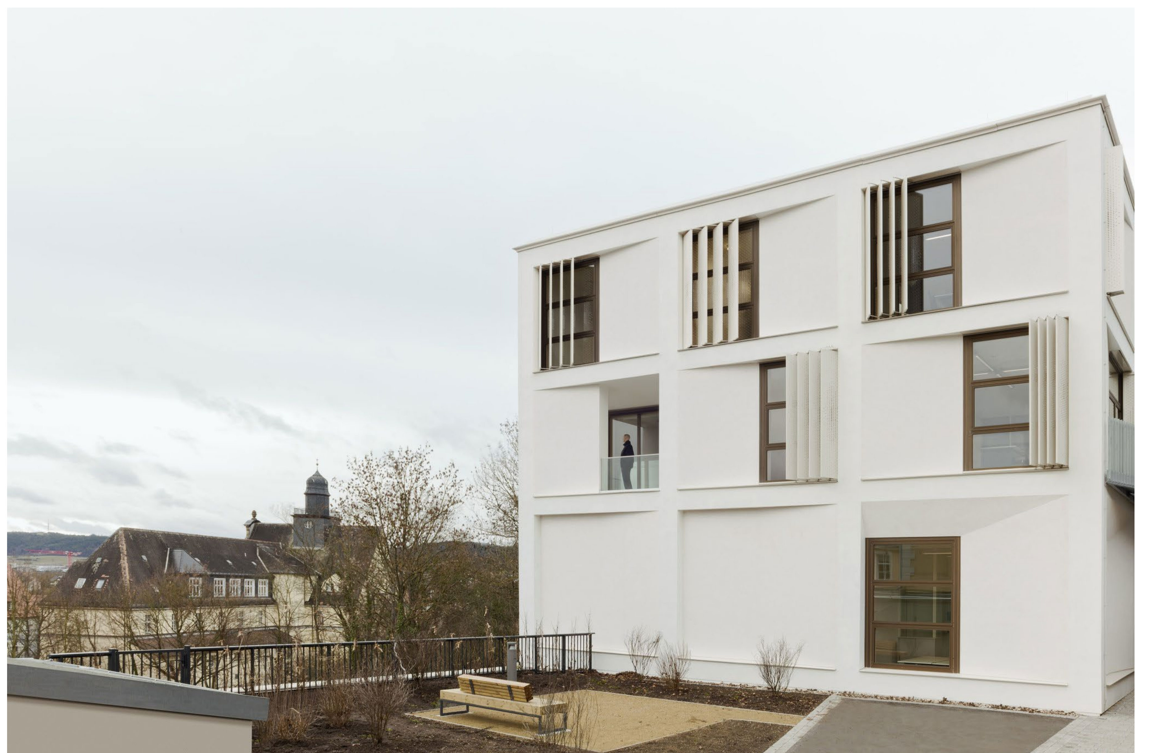
Abb.: Außenansicht der drei oberirdischen Geschosse
