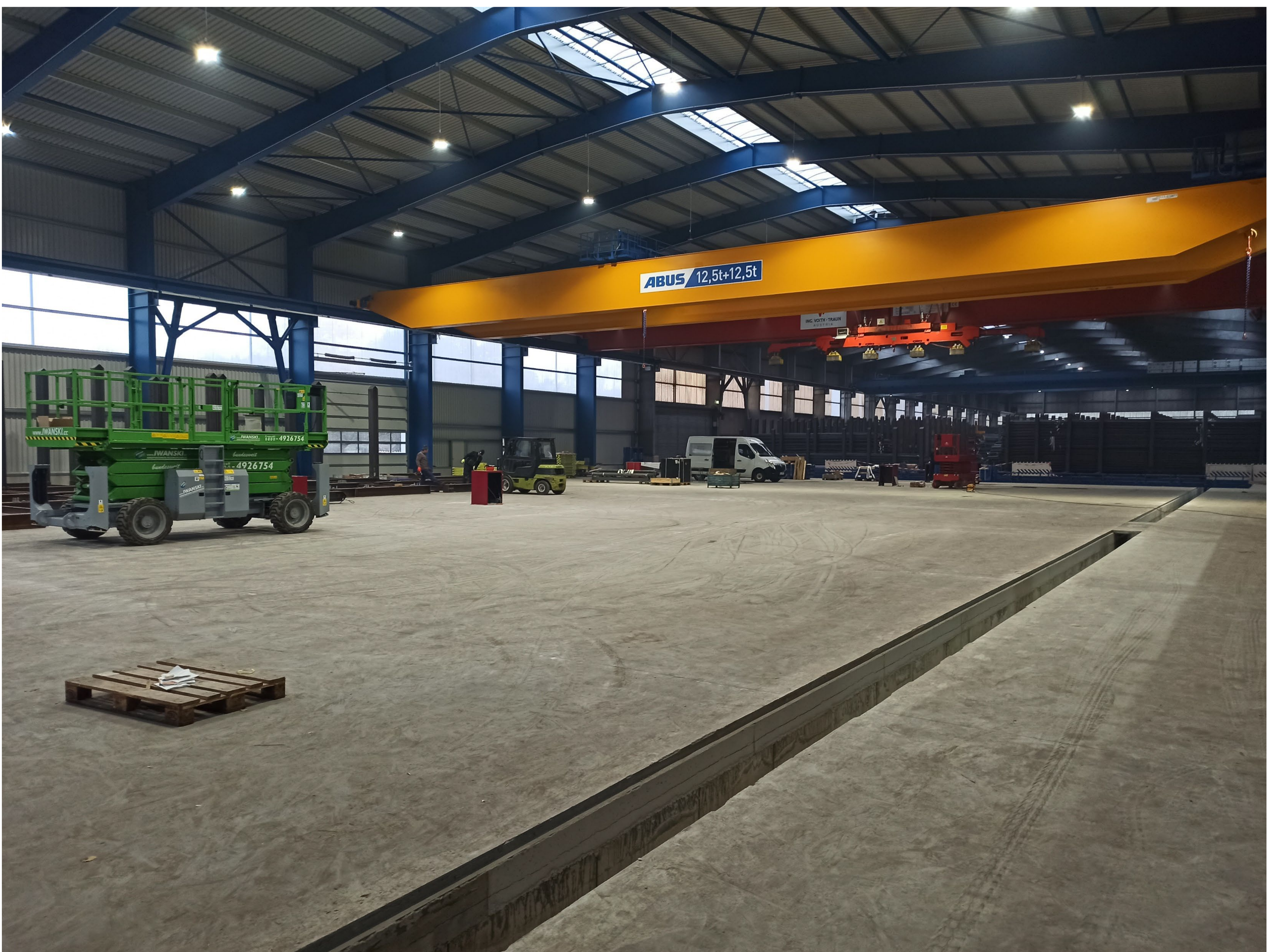
Abb.: Innenbereich Halle mit Kranbahn
