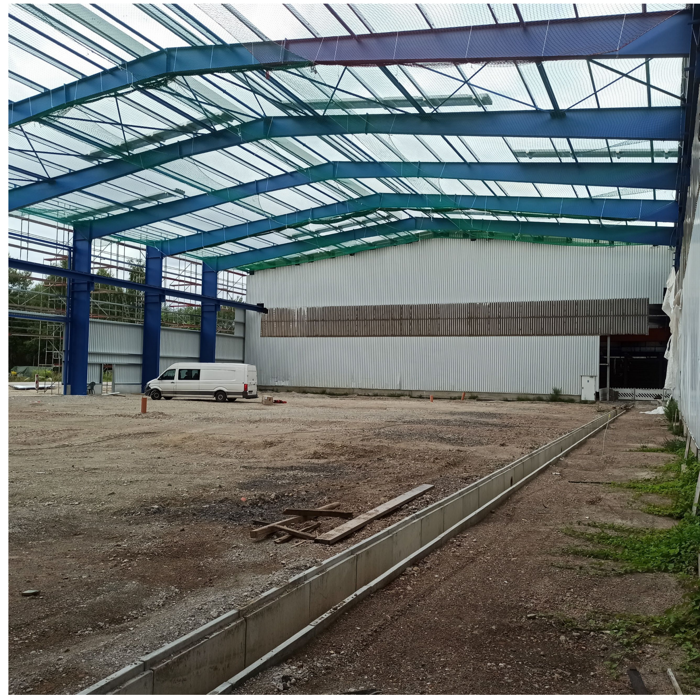
Abb.: Hallenbau Innenbereich
