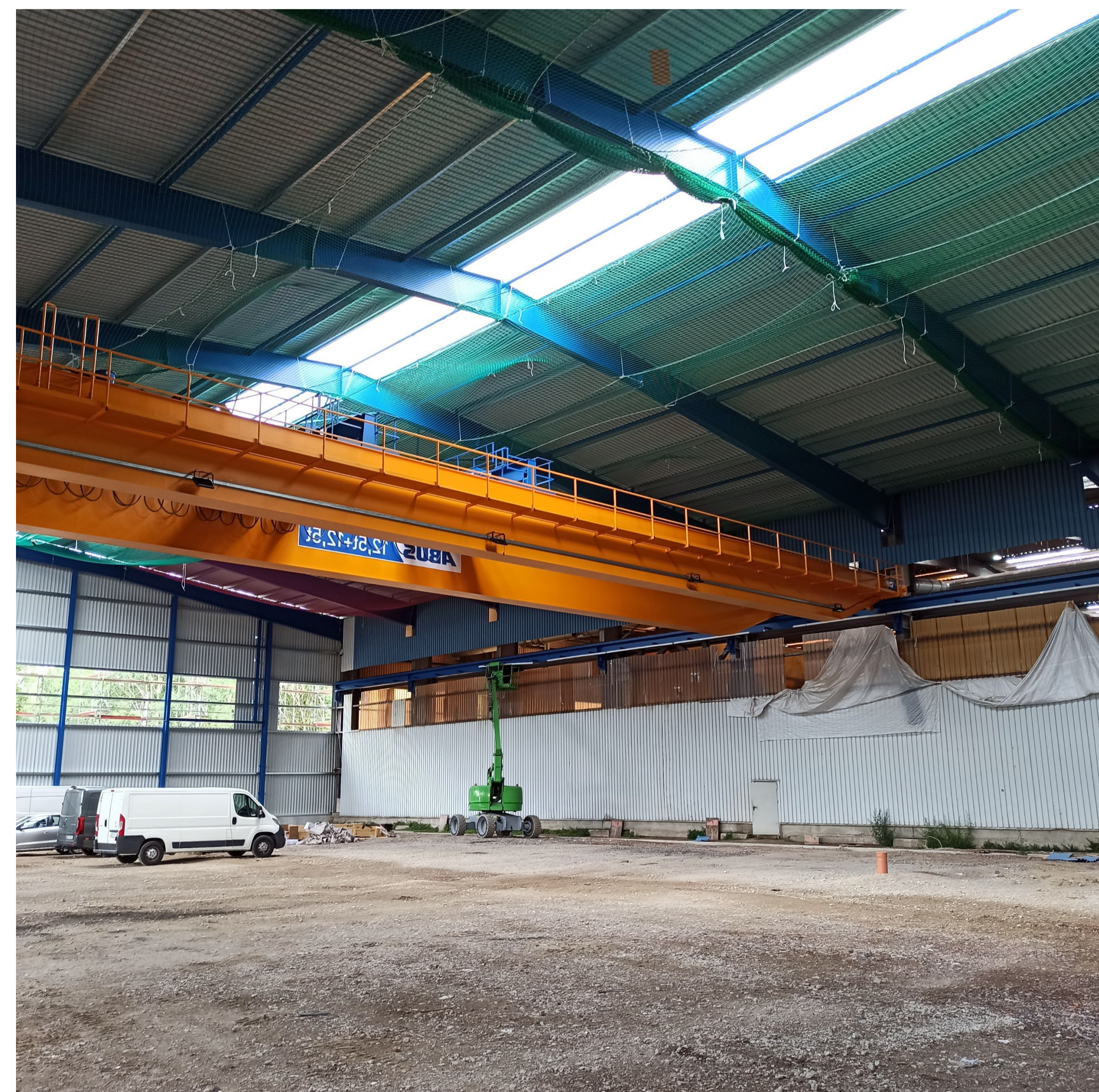
Abb.: Hallenbau Innenbereich
