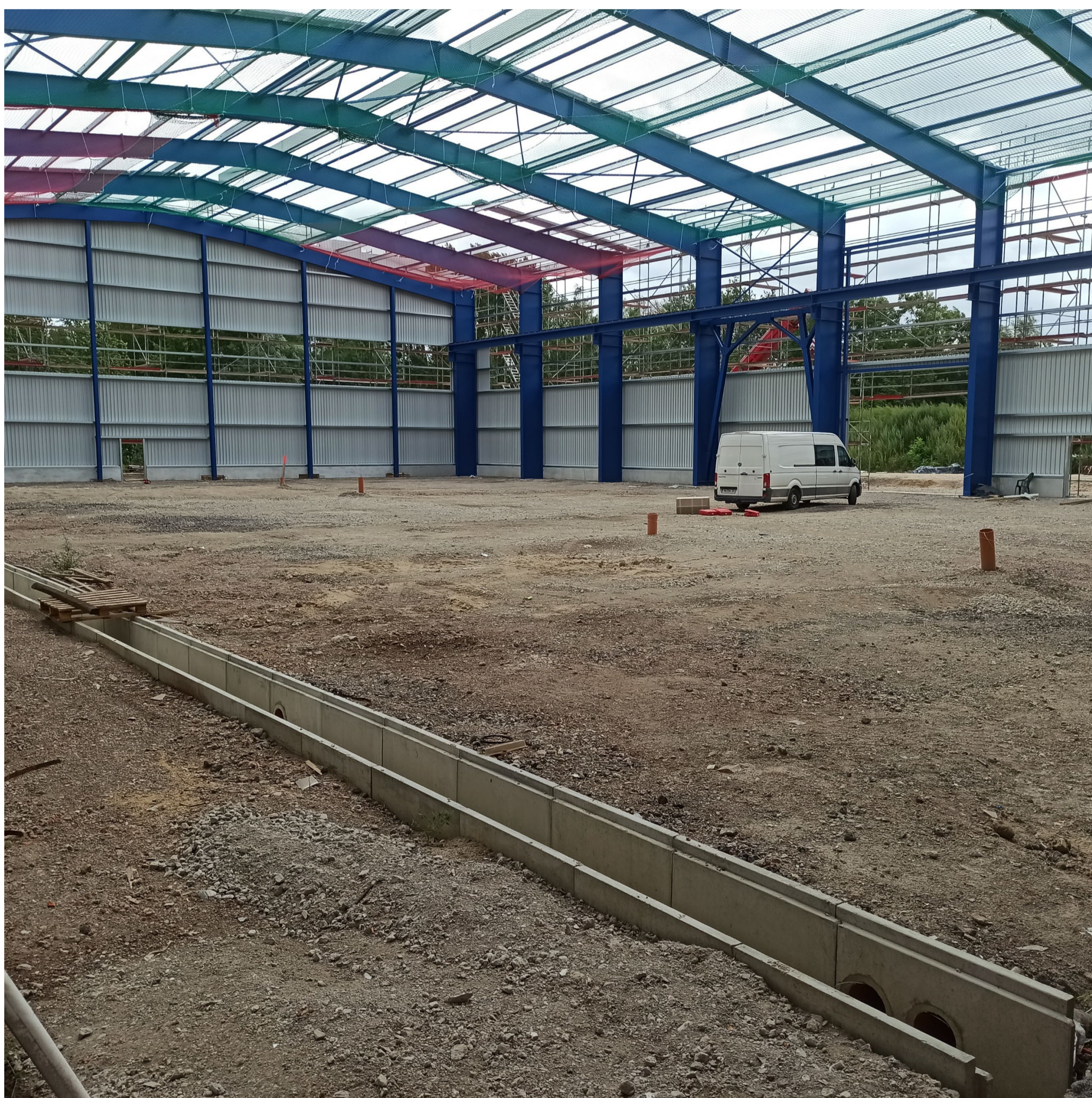
Abb.: Hallenbau Innenbereich
